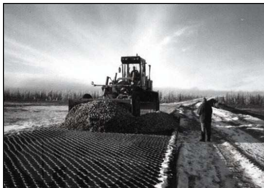
Rys. 8. Zasypywanie kruszywem komórek geosiatki za pomocą równiarki
