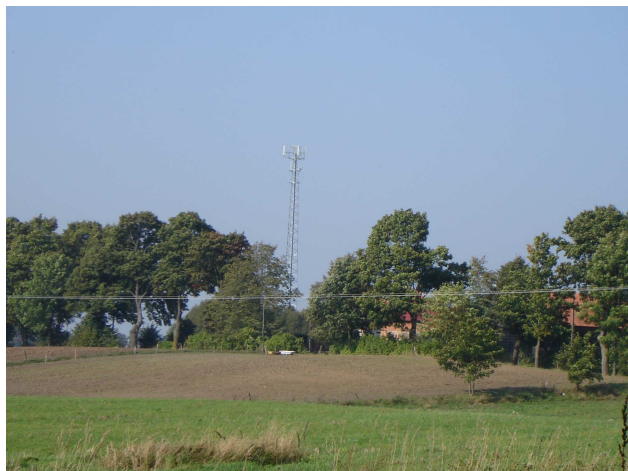
Fot. 26. Stacja telefonii komórkowej we wsi Bredynki wybudowana w 2004 roku
