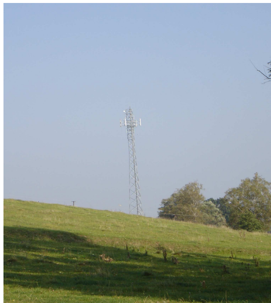
Fot. 27. Stacja telefonii komórkowej we wsi Wilimy wybudowana w 2005 roku w okolicy jeziora Dadaj
