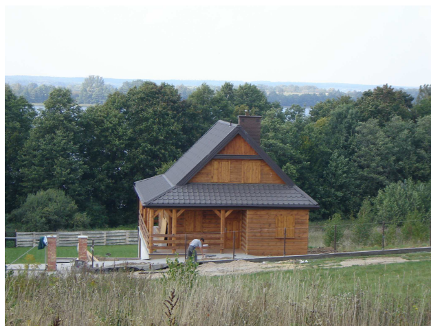
Fot. 17. Słoneczny Brzeg – zabudowa letniskowa
