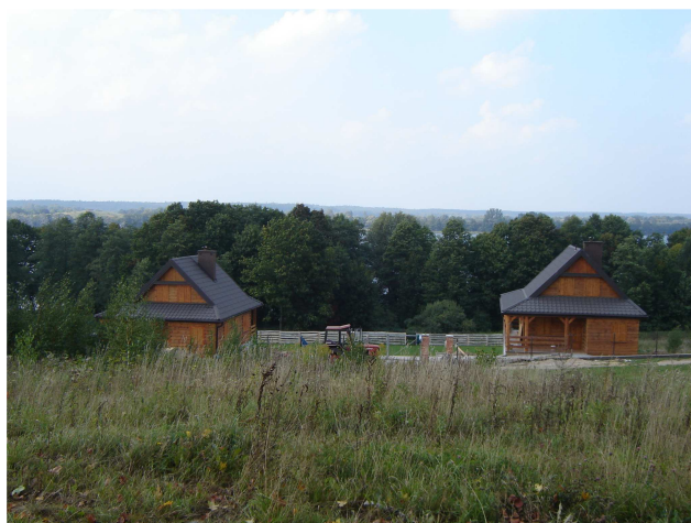
Fot. 16. Słoneczny Brzeg – zabudowa letniskowa
